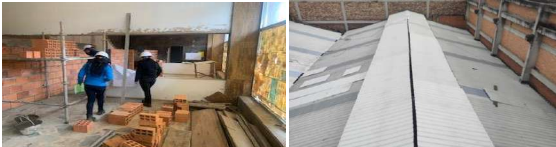
Avance en cubierta y adecuaciones locativas administrativas del proyecto CER.
