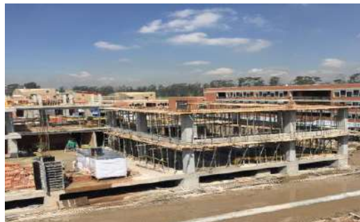
Unidad estructural 2_CAE
