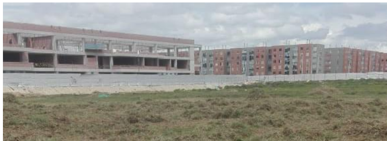
Descapote y cerramiento del lote.
