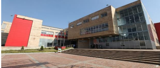
Centro de Comando Control Comunicaciones y Computo (C4) derecha de la imagen y Unidad Administrativa Especial Cuerpo Oficial Bomberos de Bogotá Izquierda de la Imagen.
