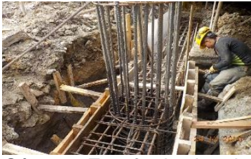
Sótano - Encofrado viga de cimentación
