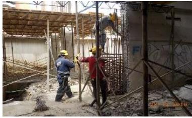
Sotano - Acero de refuerzo columna nueva
