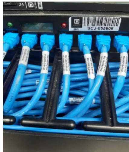
Imagen 15, Equipos de red sin diagramación y puertos del switch sin registro de utilizados y no utilizados en el DC de Kennedy.
