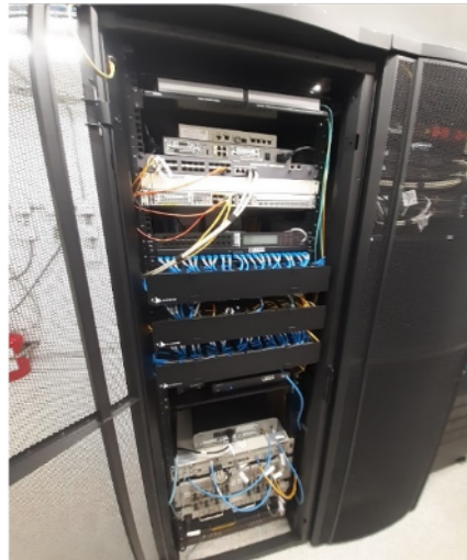
Imagen 15, Equipos de red sin diagramación y puertos del switch sin registro de utilizados y no utilizados en el DC de Kennedy.
