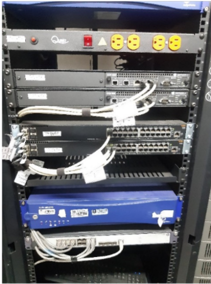
Imagen 14, equipos de red sin diagramación y puertos del switch sin registro de utilizados y no utilizados en el DC de Puente Aranda.
