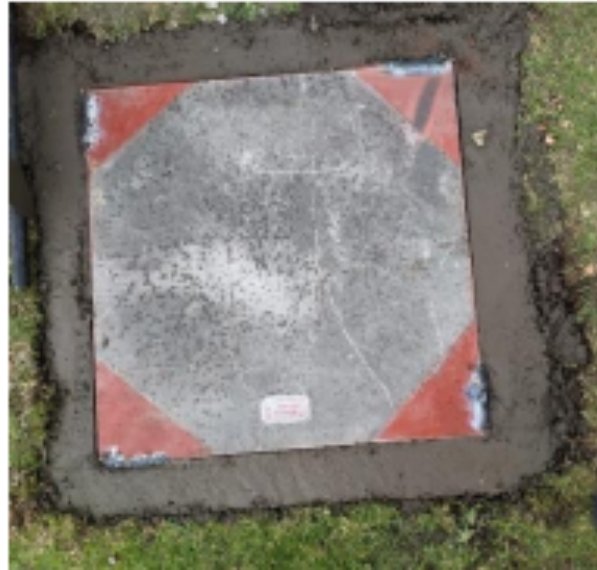
Imagen, foto instalación y acondicionamiento de SPT y Tapas
