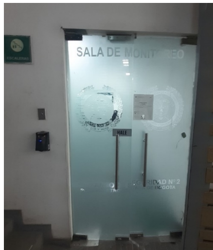
Imagen 25, Puerta de seguridad de la sala de monitoreo de Ciudad Bolívar averiada y dispositivos para control de acceso con huella dactilar por dentro y por fuera del DC dañados.
