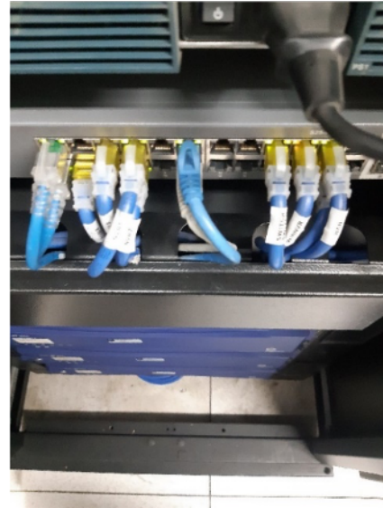
Imagen 14, equipos de red sin diagramación y puertos del switch sin registro de utilizados y no utilizados en el DC de Puente Aranda.
