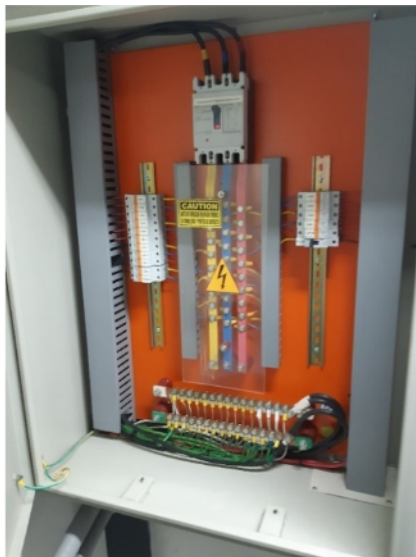
Imagen 13, cajas metálicas de red eléctrica regulada y no regulada del cuarto de datos de Puente Aranda abiertas.
