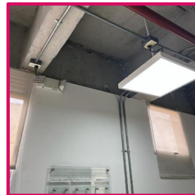
15Filtración reparadas en ventanearría de oficina archivo de policía
