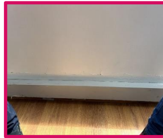
instalación de canaleta
