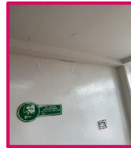
resane de paredes por filtración de agua en techo
