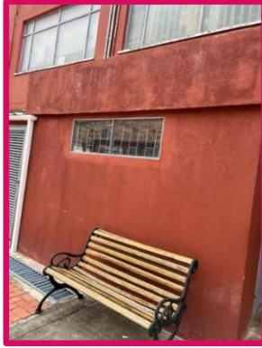
Impermeabilización ventanearía de fachada y patio
