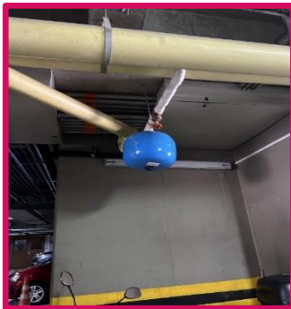
Instalación campanas red de suministro
