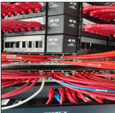
Imagen No.24. puertos utilizados y no utilizados sin registro, ni control - Cárcel Distrital
