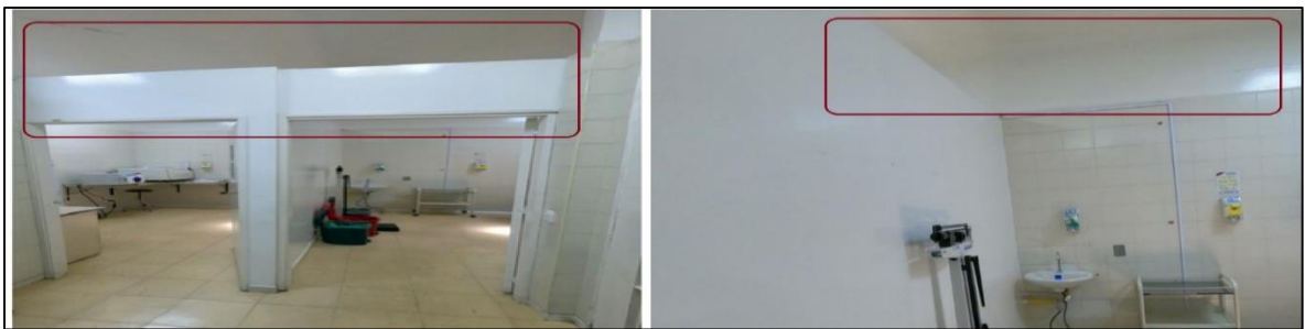
Imagen No.59. Techos de consultorios médicos tercer piso.
