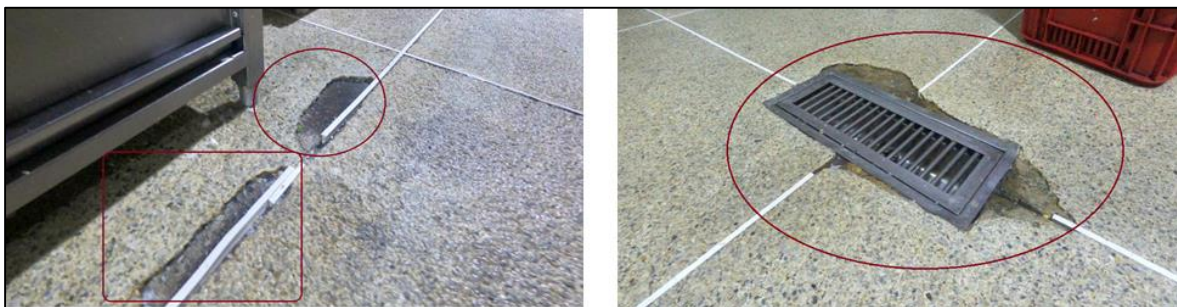
Imagen No.36. Fuente: Visita Zona de Cocina, DCC.
