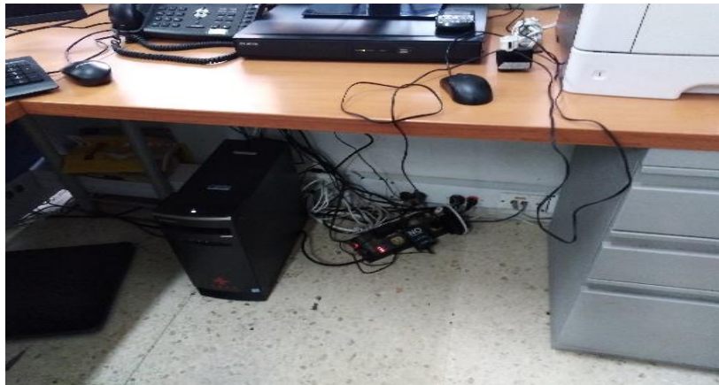
Imagen No. 3. Cableado expuesto
