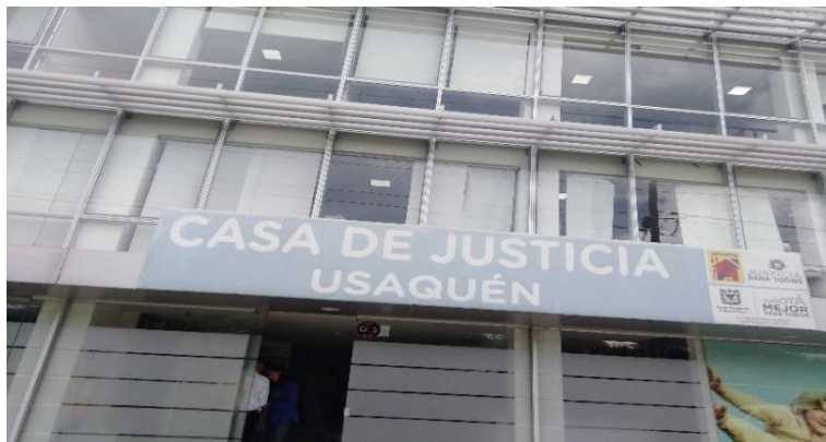
Imagen No. 22 Fachada nueva Casa de Justicia
