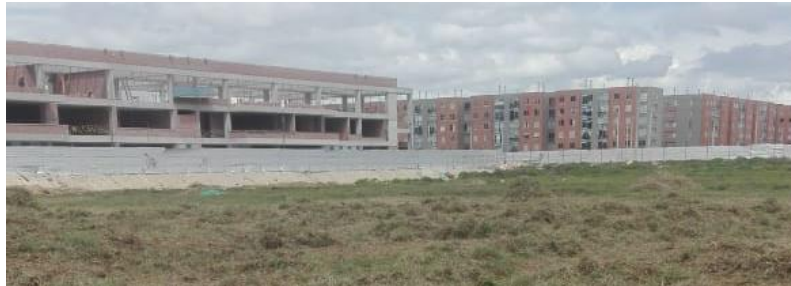
Descapote y cerramiento del lote.
