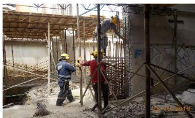
Sotano - Acero de refuerzo columna nueva
