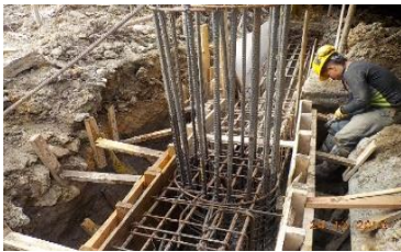
Sótano - Encofrado viga de cimentación
