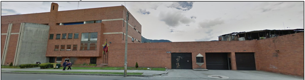
Imágenes 15: Fachada Entrada Administrativa Cárcel Distrital
