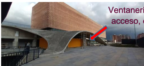
Imagen No 8: Acceso principal. (ingreso principal – “Bóveda”)
