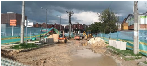
Imagen No 5: Vía de acceso al proyecto (Carrera 56) en intervención por parte de la Alcaldía Local de Teusaquillo
