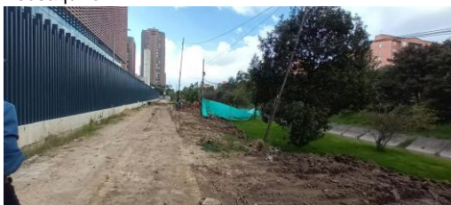
Imagen No 7: Ronda del canal San Francisco. Obras en ejecución desde obtención del POC.
