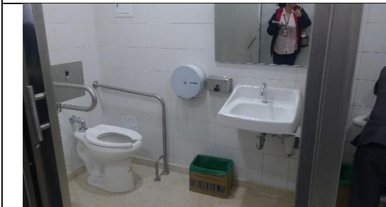
Foto No. 3 Instalación de baterías de baños de las oficinas, barras de seguridad en acero inoxidable, espejo, protector para papel higienico, dispensador para jabón y perchas
