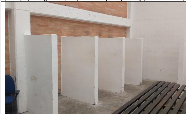
Foto No 5 Adecuación de módulos en el patio de requisas, mediante la construcción de muros en mampostería.
