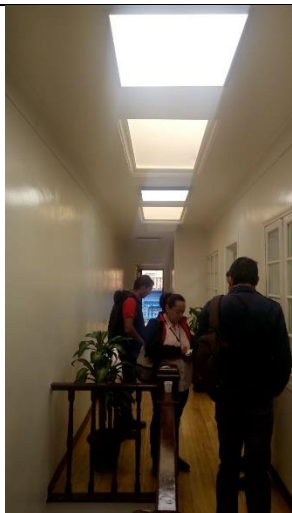
Foto No. 3 Se realizó la pintura general en el primero y segundo piso, con pintura epóxica.
