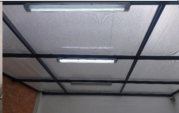
Foto No 6 En el patio de requisas se instaló una marquesina soportada en una estructura de aluminio y con tejas en policarbonato alveolar. Se instalaron lámparas herméticas.
