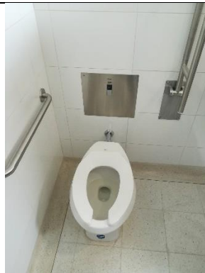
Foto No. 4 Adecuación baños para personas con movilidad reducida : sanitario, fluxómetro con sensor, barra de seguridad abatible en acero inoxidable ( derecha) barra de seguridad de sobrepasar (izquierda), instalación de piso y enchape en cerámica y guardaescoba en media caña.
