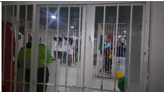
Foto No. 4 Construcción de nueva zona de celdas, con piso en granito, adecuación de rejas.
