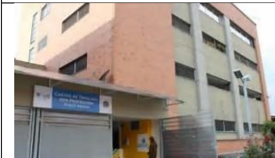
Foto No. 1 Edificio de la Unidad Permanente de Justicia-UPJ de Puente Aranda.
