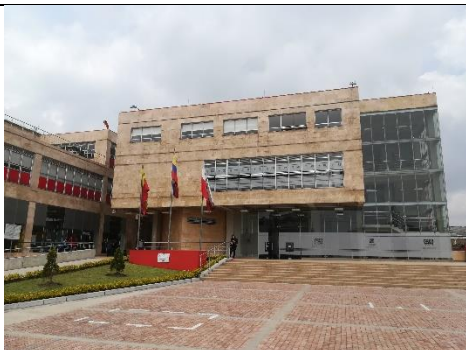
Foto No. 1 Centro de Comando, Control, Comunicaciones y Cómputo C-4, donde se realizaron adecuaciones y labores de mantenimiento correctivo y preventivo.
