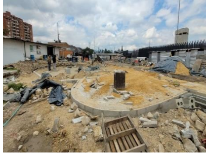
obras área de ocupación de cauce
