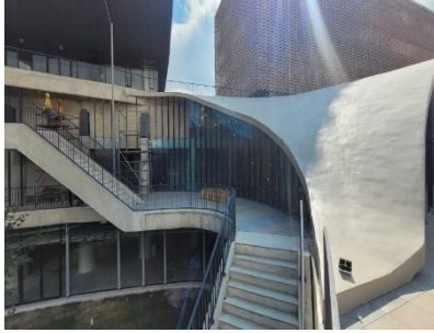
Avance la ventanería de la bóveda
