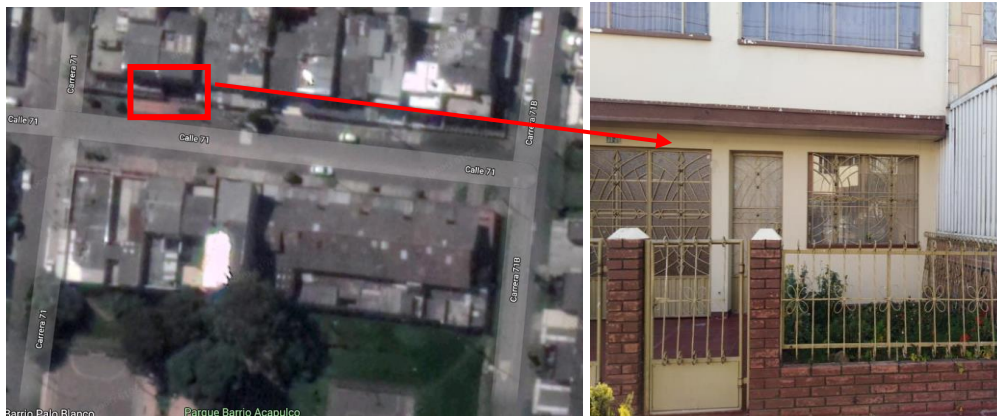
Imagen No. 53 – Soporte ubicación Calle 71 N. 71-23 HYUNDAUTOS
