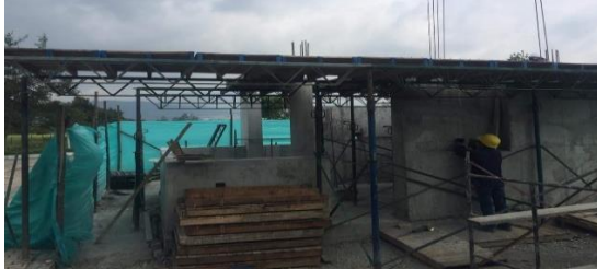
Actividad de armado de formaleta para cubierta de CAI.
