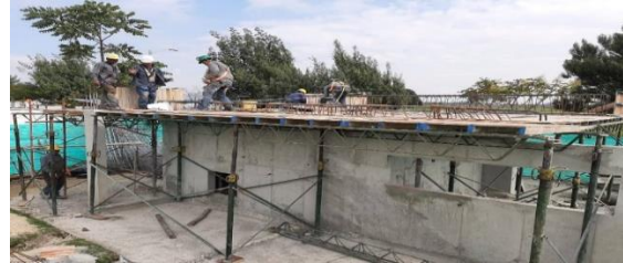
Actividad de armado de hierros para cubierta.
