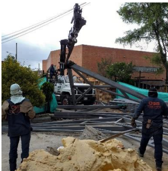
Inicio montaje Cubierta fuerte Carabineros Gaitana de Suba.
