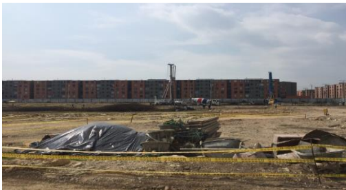
Nivelación y adecuación de terreno
