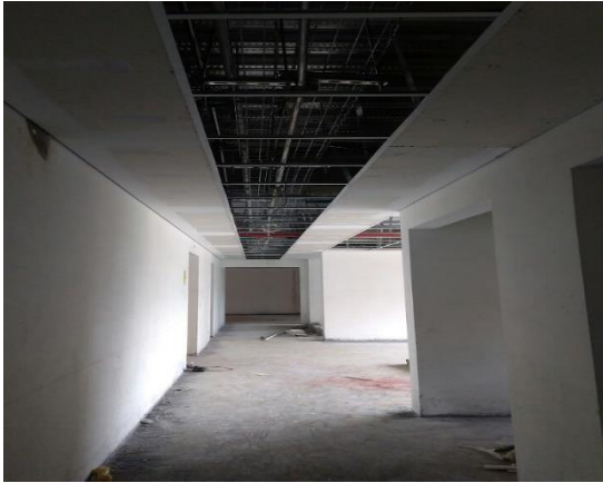
Colocación de cable 6A para voz y datos
