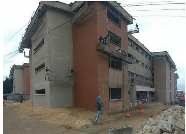
Lavado de fachada exterior y destroncado de piso
