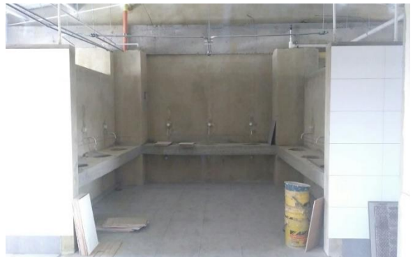
Colocación de carpintería metálica de superboard en pasillos exteriores y trabajos de enchapes para áreas de lavamanos
