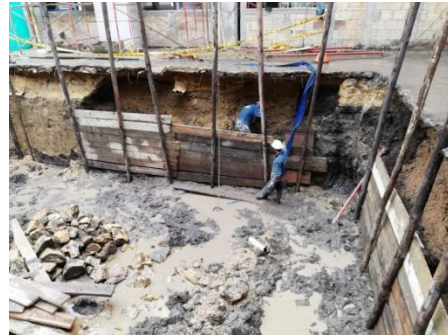
Excavación tanque contra incendio
