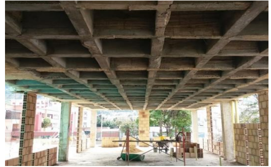
Reforzamiento de viguetas
