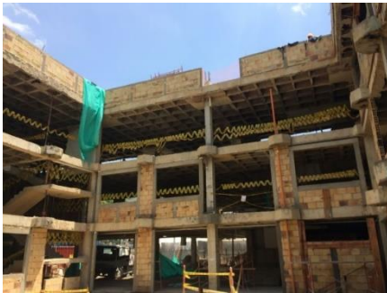
Mampostería de Fachada
